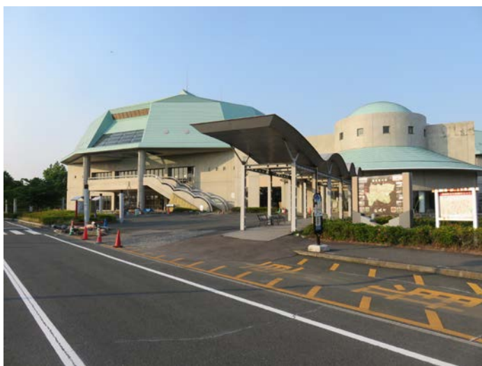
益城町総合体育館
